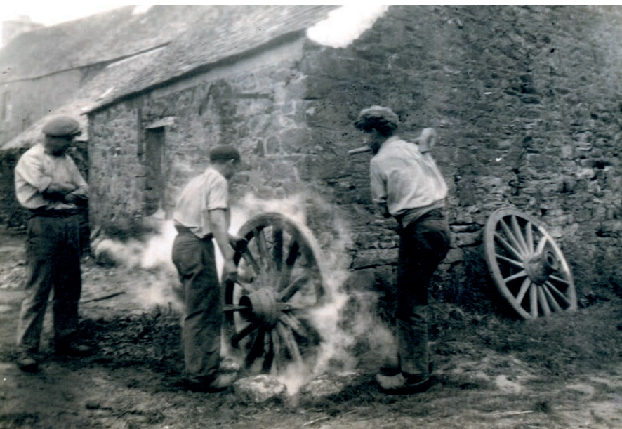
▲ PHOTO VERS 1950, CERCLAGE D'UNE ROUE À GUICLAN De gauche à droite : Hervé Kermarrec (frère de Jean-Marie), Alain Bihan de Taulé et Jean-Marie Kermarrec qui tenait la forge (derrière le bar de Jeannine Le Rest).
